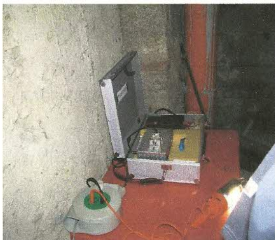
Stazione di Pogno in fase di installazione
